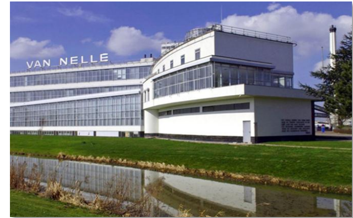
ESCO (Energy Saving Company), e.g. Van Nelle
